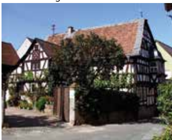
Erbaut auf den Grundmauern einer fränkischen Schmiede, das markante Fachwerkhaus „Alte Schmiede“ in Kiedrich
